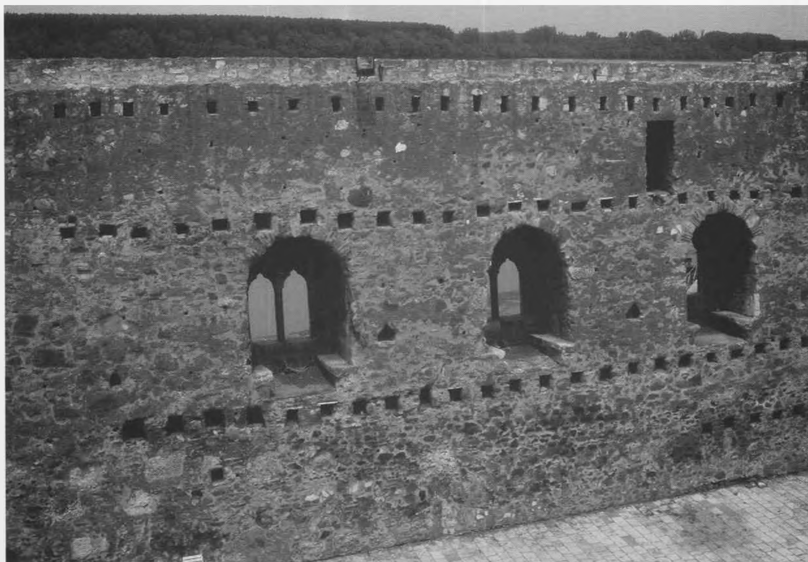
Смедерево, 1430. године, део палате у Малом граду. Виде се отвори у зиду од греда које су чиниле спратне конструкције.
